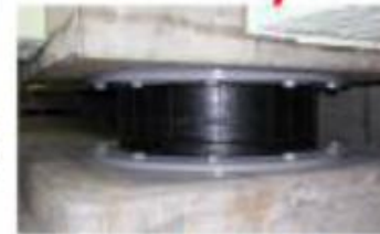
8プラグ入り積層ゴム(8台) (変形を元に戻し揺れを吸収する)
