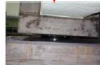
滑り支承(12台) (摩擦が少ない板上を滑る)
