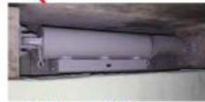
オイルダンパー(4台) (地震の揺れを吸収する)
